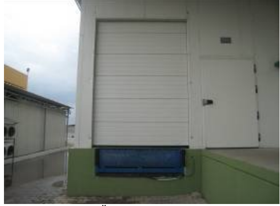
SOĞUK HAVA DEPOSU
