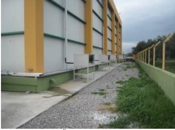
SOĞUK HAVA DEPOSU
